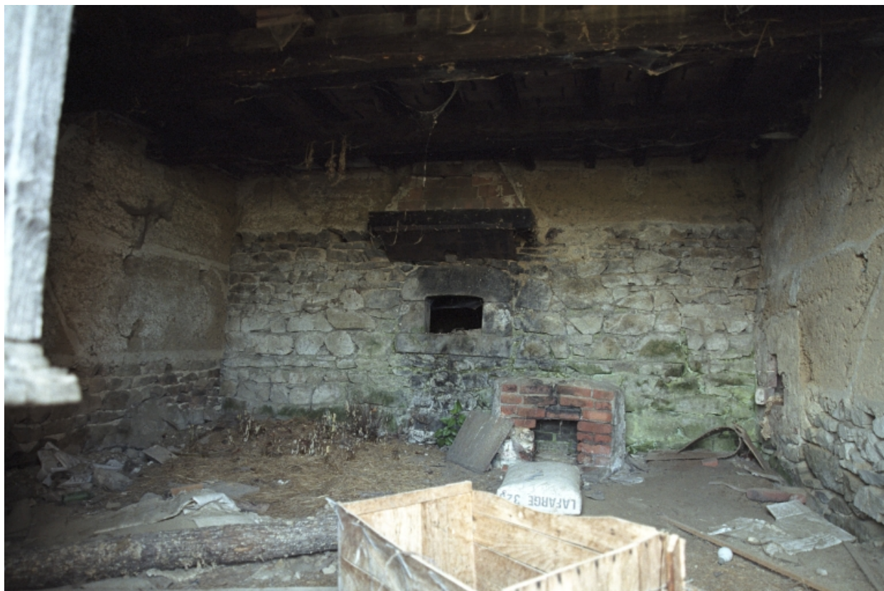
Vue intérieure du fournil.
