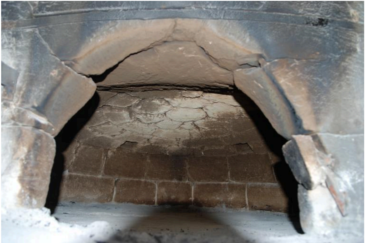
Vue intérieure de la voûte du four
