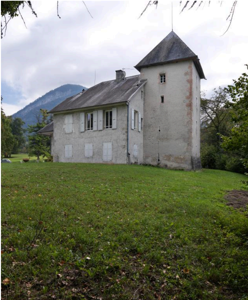
Vue d'ensemble de trois-quarts arrière droit (nord-ouest) de la maison.
