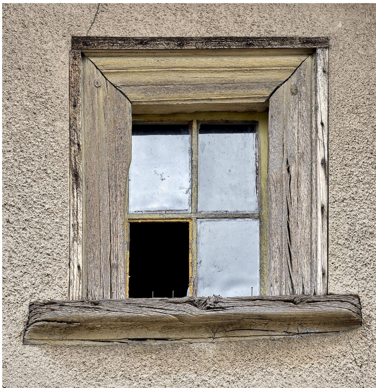
Elévation sud de la maison, étage de comble, détail d'une baie à encadrement bois.
