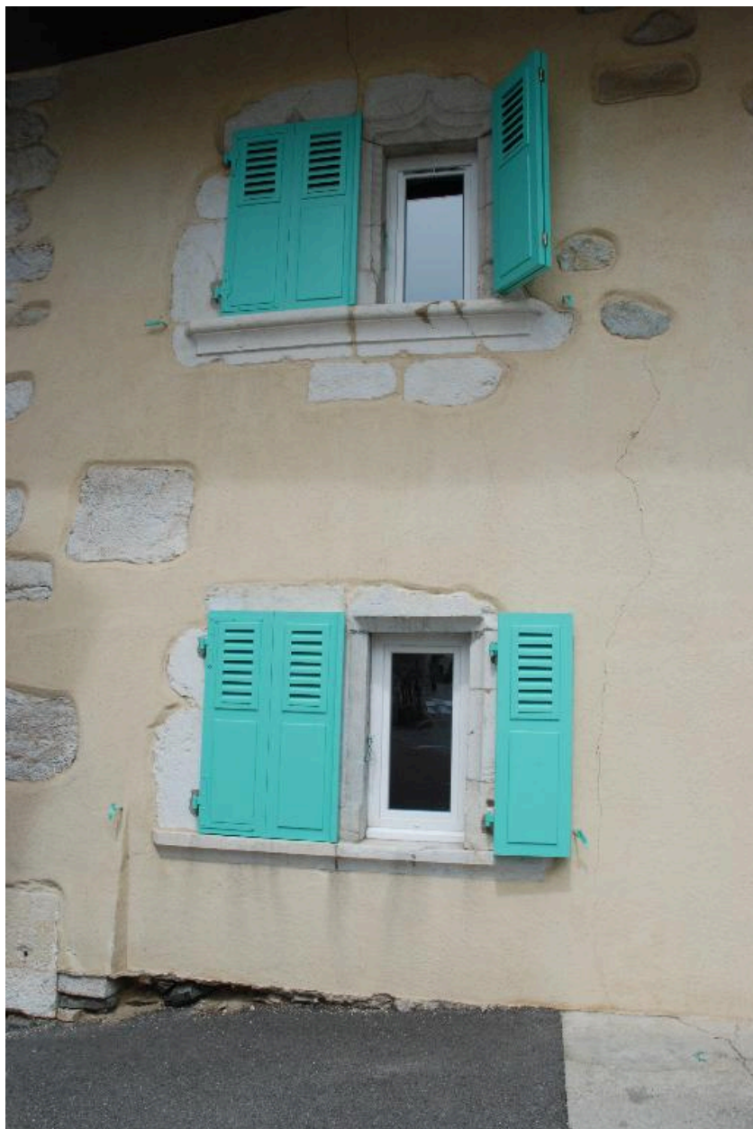
Vue des fenêtres de la façade sud.
