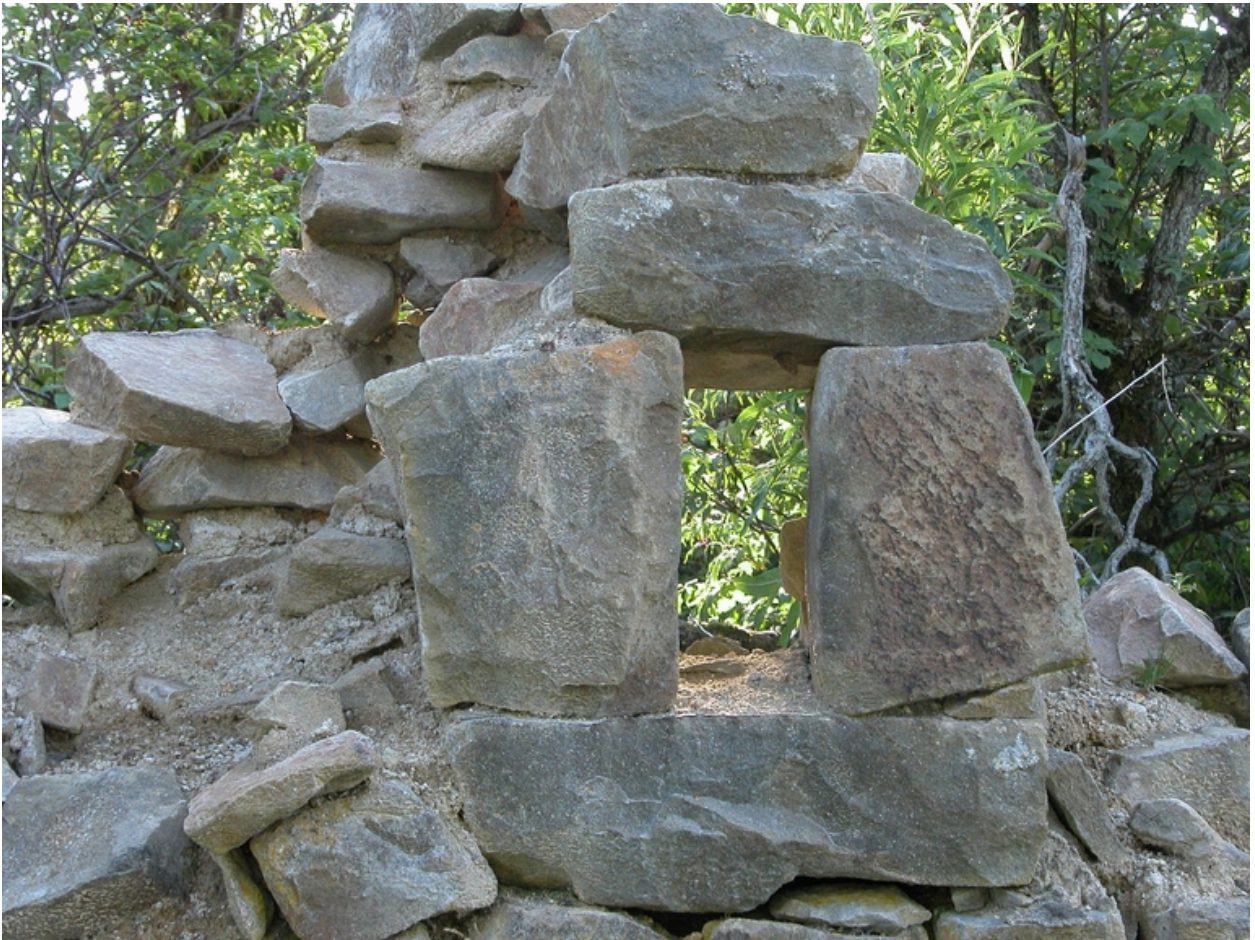
Détail de maçonnerie.
