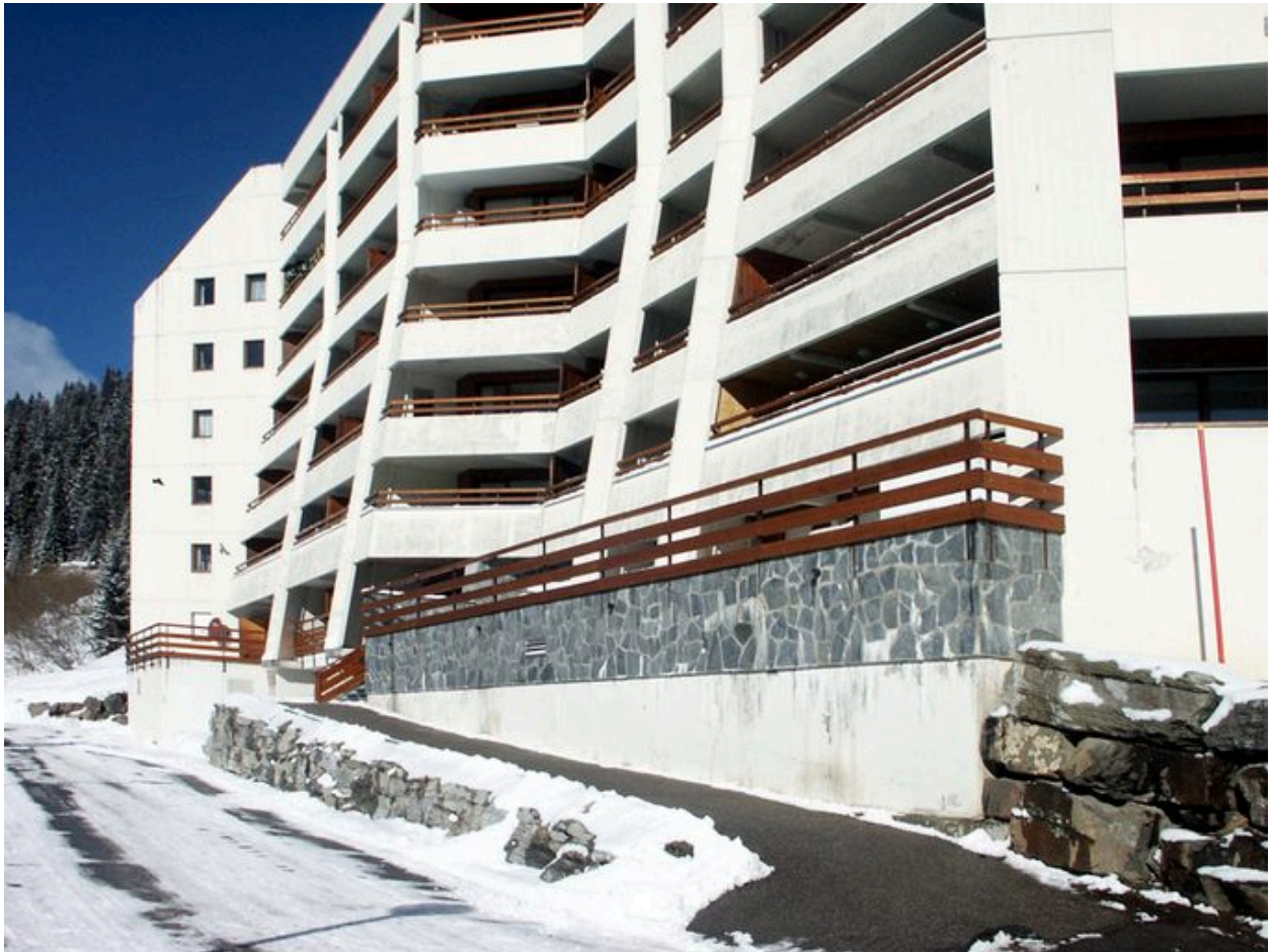
Vue depuis le sud-est
