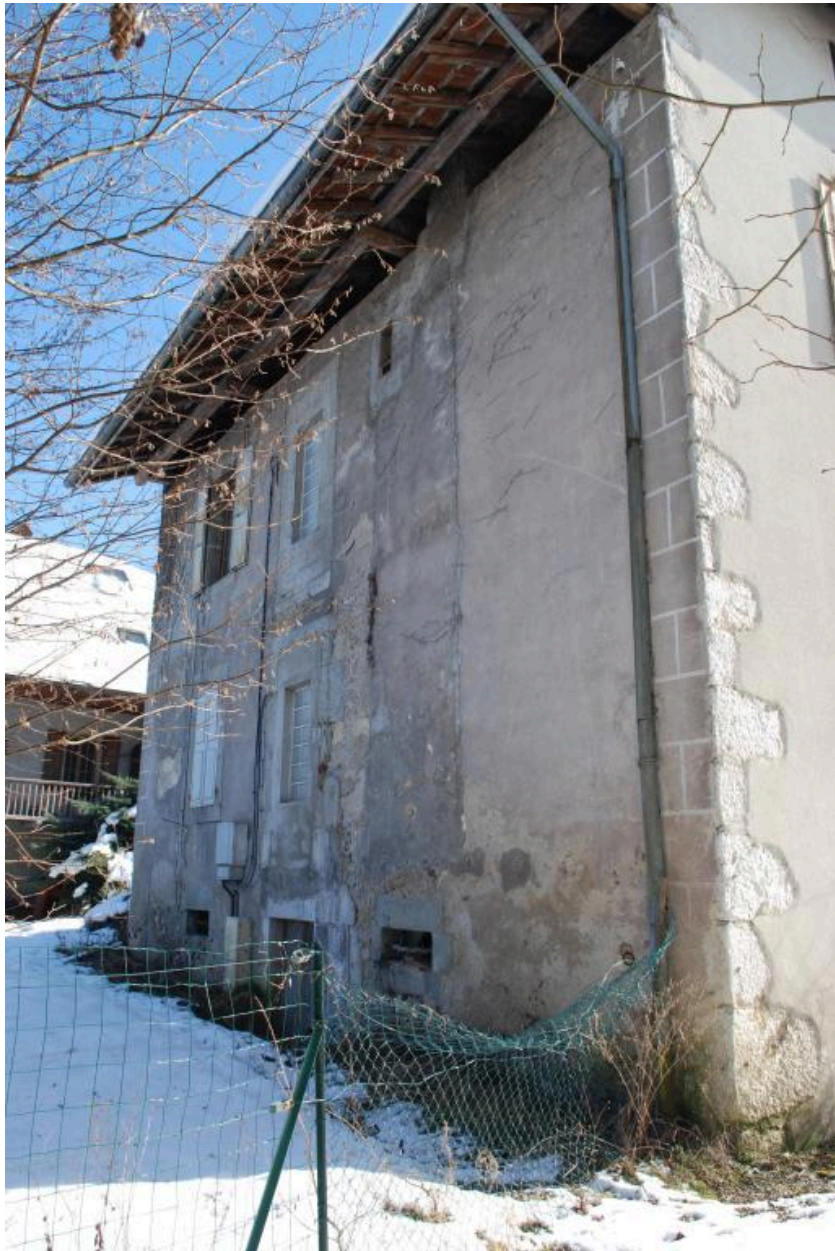
Vue d'ensemble de la façade arrière sur jardin.
