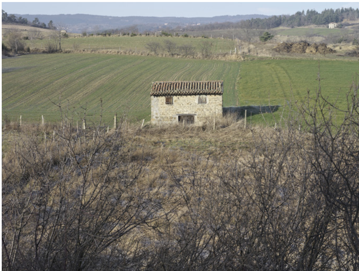
Vue générale depuis le sud.
