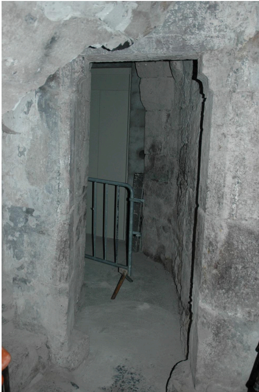
Vue intérieure des vestiges de la nef ("caveau des Augustins"), passage vers un espace situé sous le clocher (?) : porte à linteau sur coussinet.
