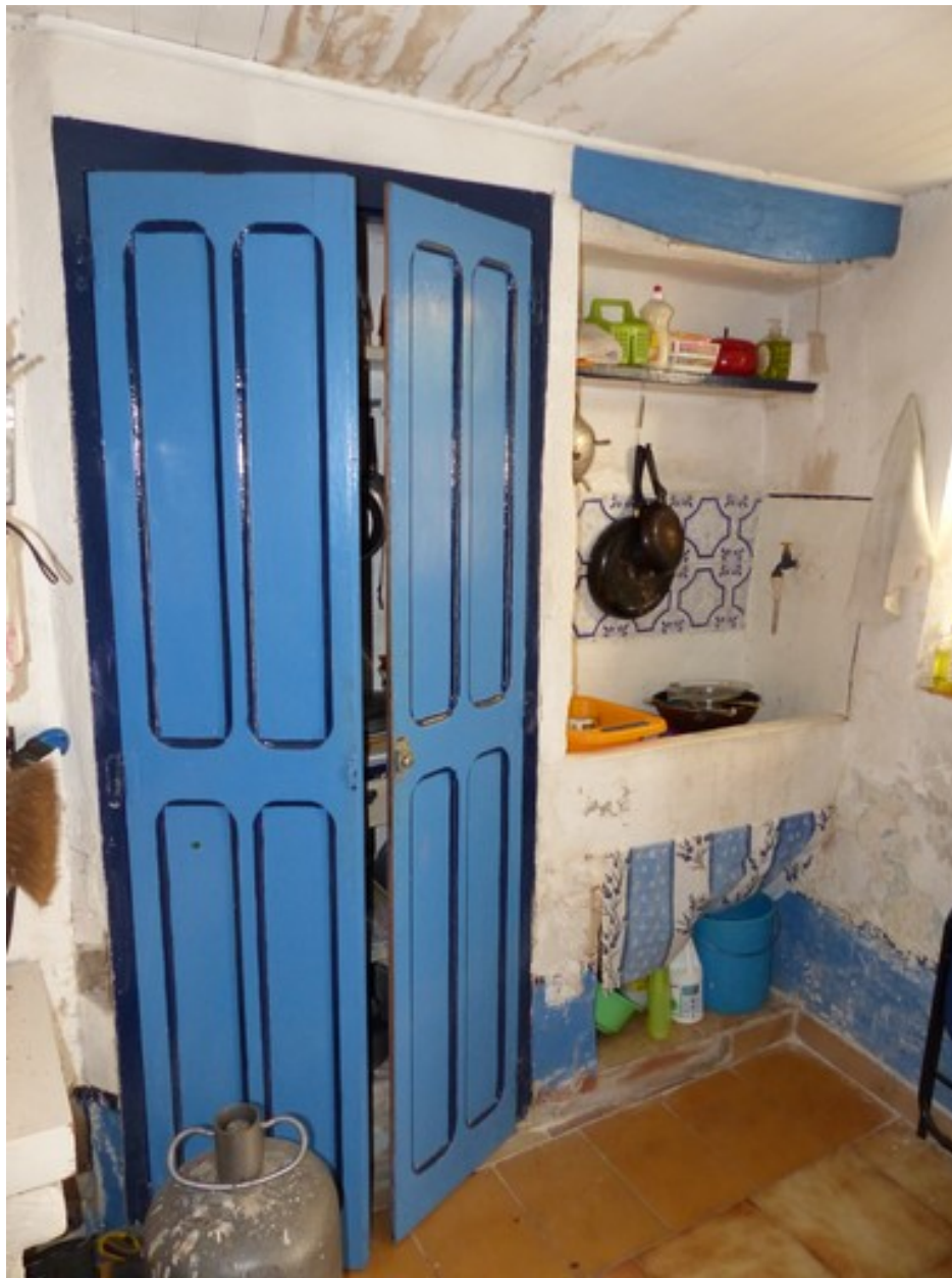
Rez-de-chaussée surélevé, cuisine. Angle sud-est, placard mural et pile d'évier.
