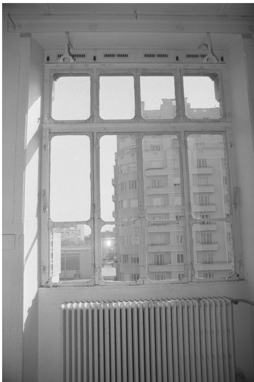
Fenêtre. Bâtiment G, 2e étage, mur sud
