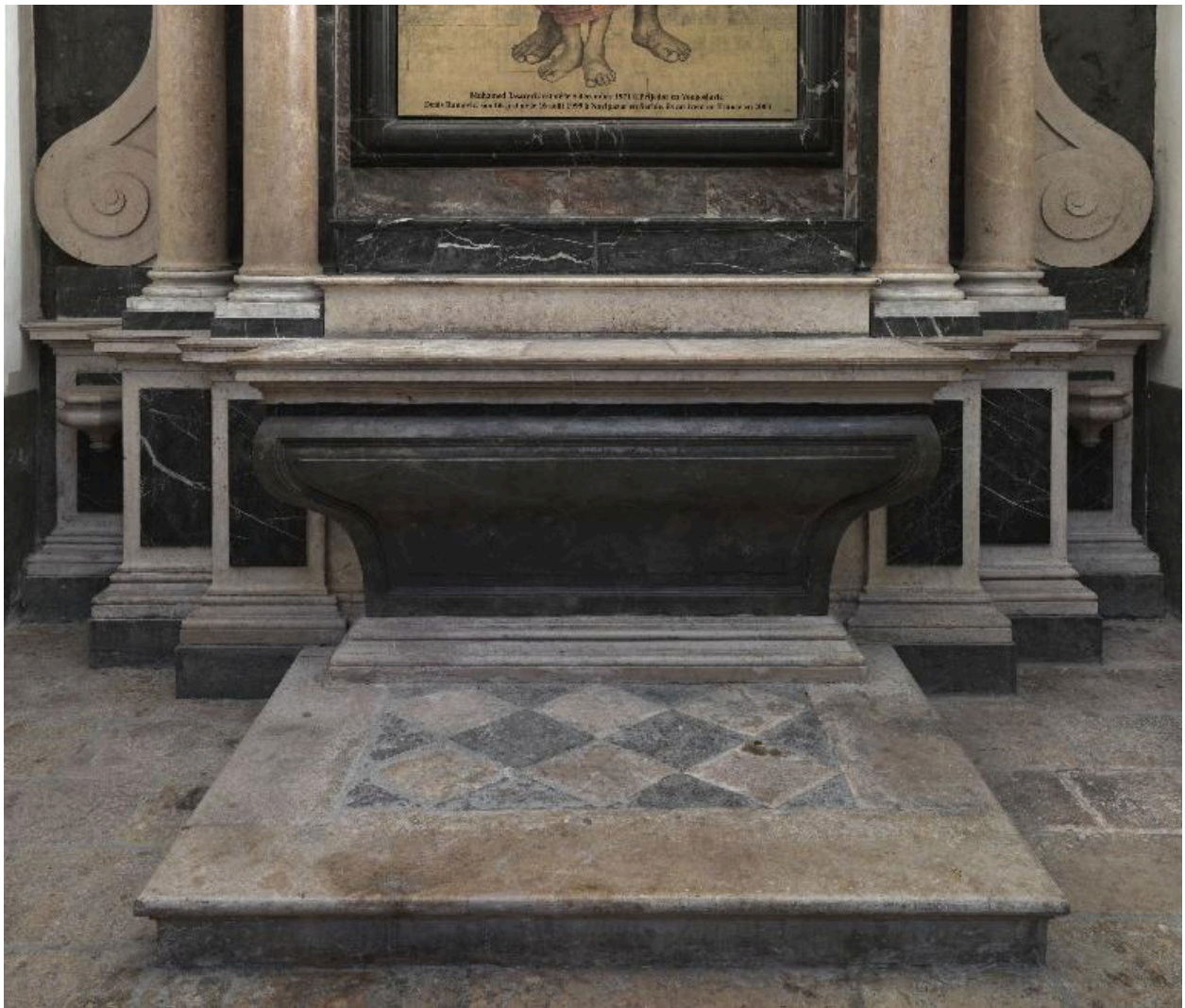
6e chapelle du bas-côté sud : détail de l'autel
