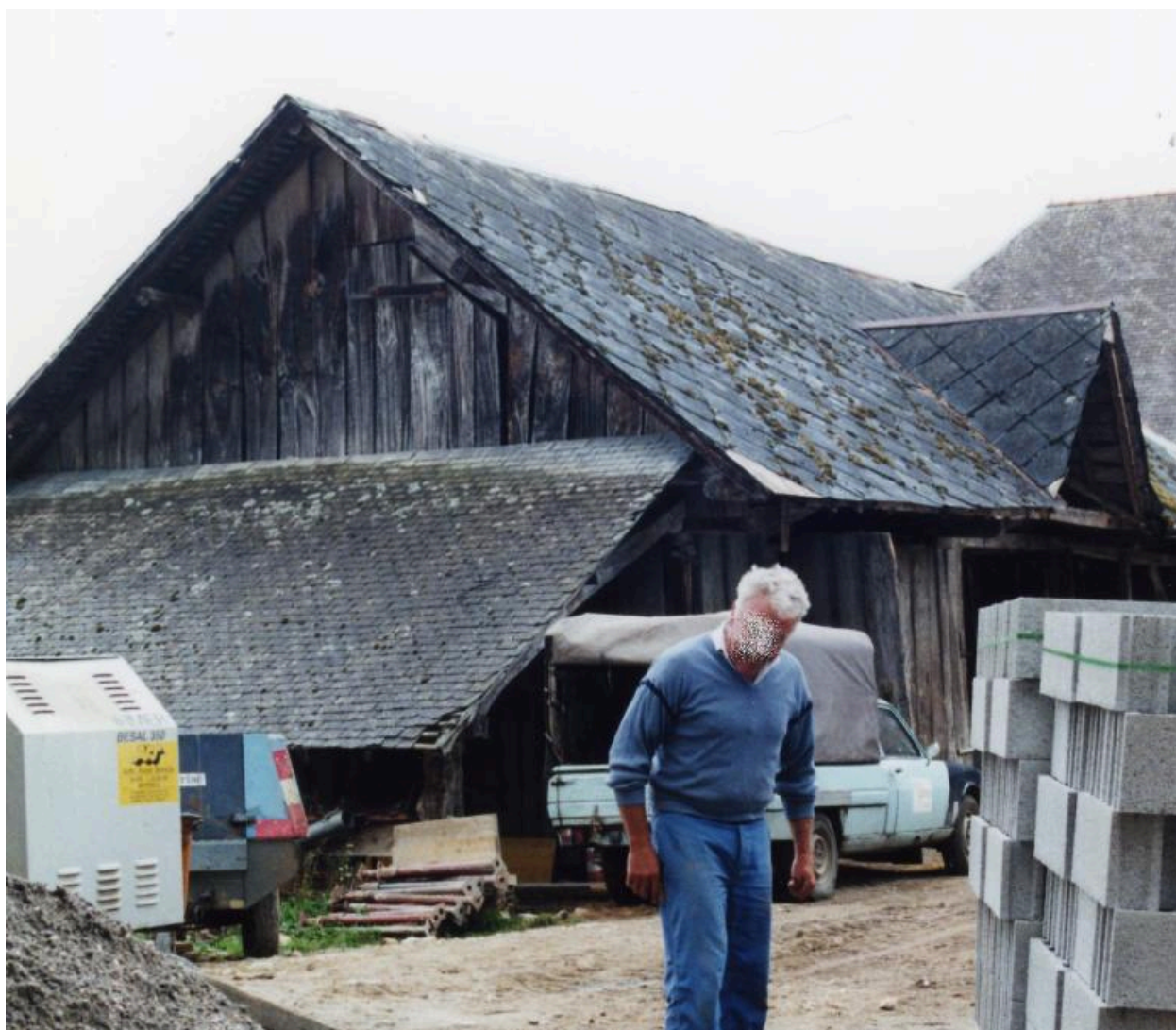
Vue de la grange-remise, depuis la cour (avant 2000).
