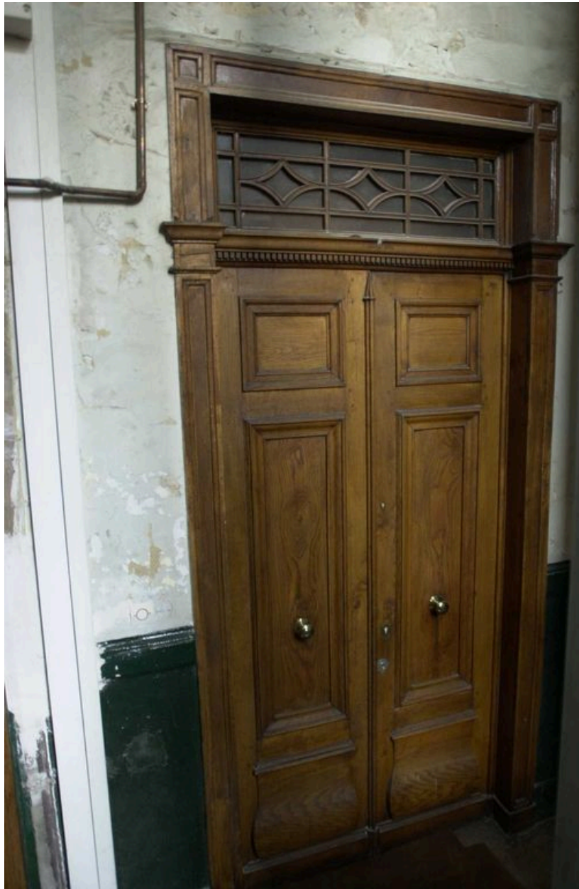
Vue d'une porte d'appartement
