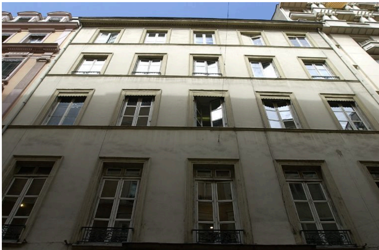
Lotissement : 6 rue Emile-Zola, façade de l'immeuble
