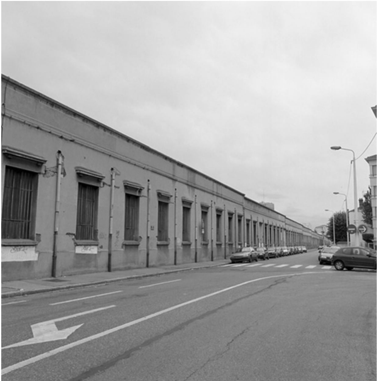
Façade rue Feuillat
