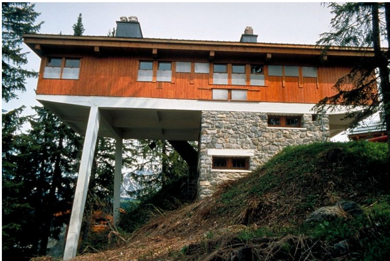
Vue de la façade nord
