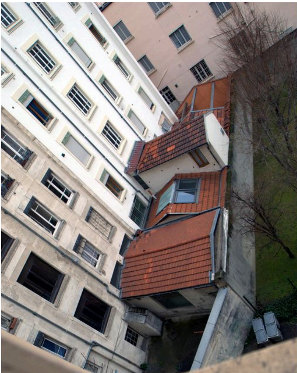
Elévation postérieure et bâtiments annexe, vue partielle
