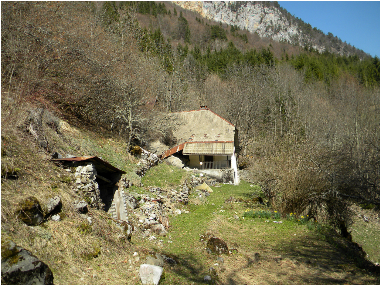
Vue de la façade sud avec l'ancien potager.
