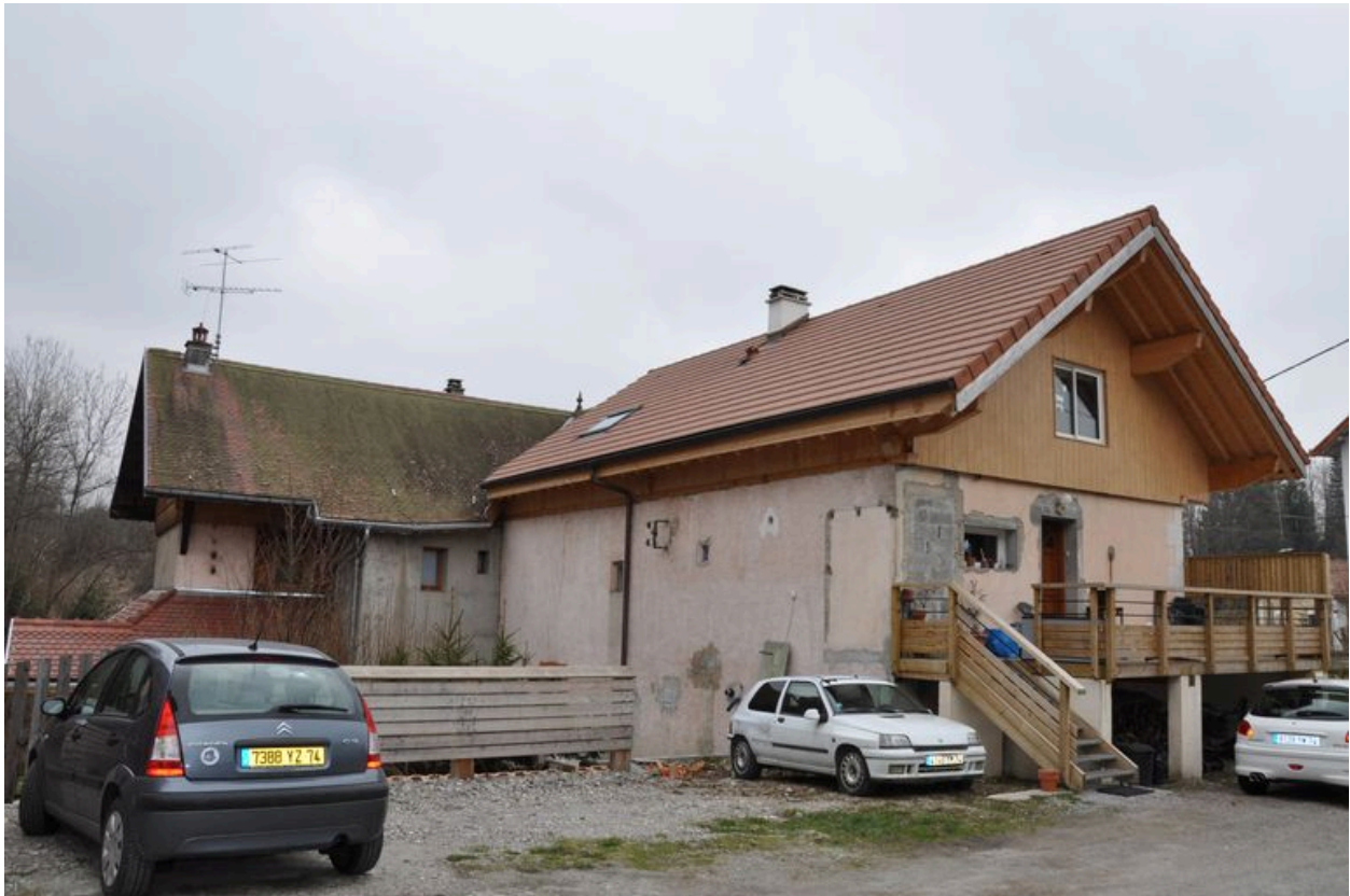
Vue du bâtiment de la scierie prise depuis la cour intérieure
