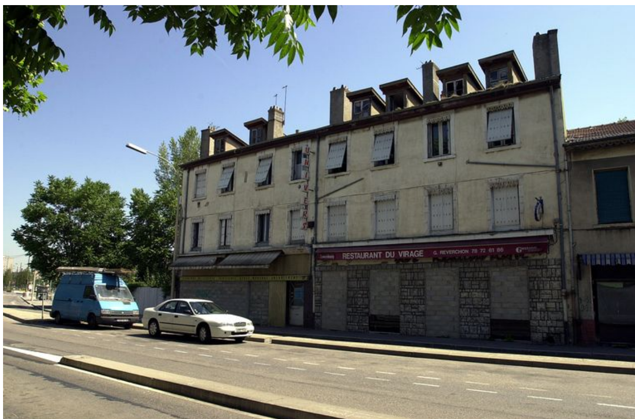
Façade sur la rue Alexander-Fleming
