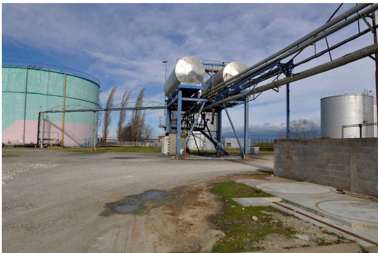
Vue de l'extérieur
