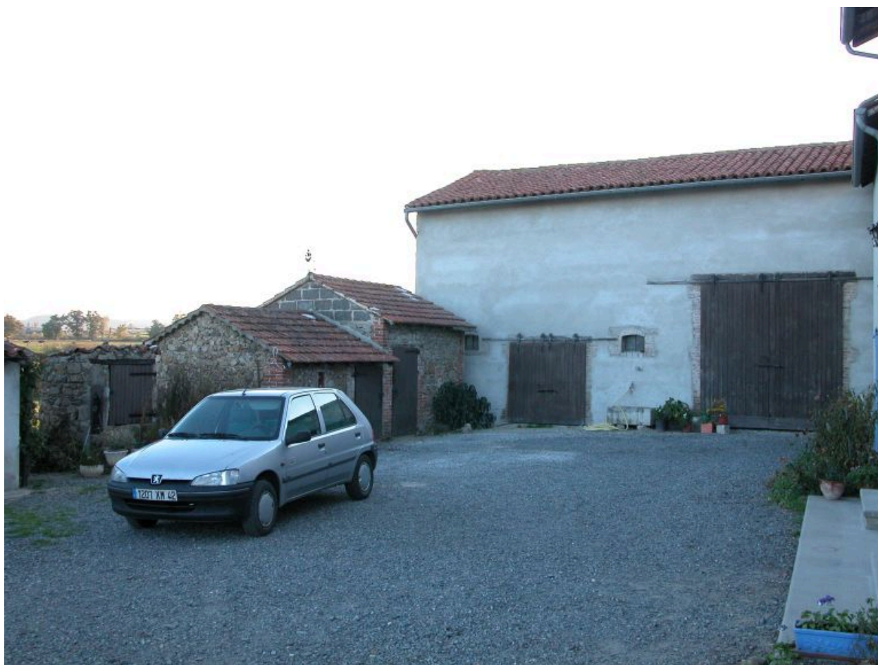
Vue d'ensemble de la grange-étable.
