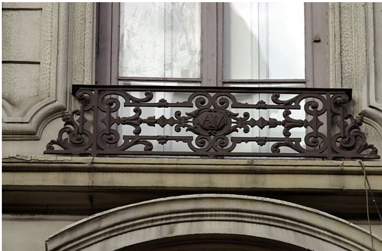
Façade principale, 3e niveau, détail d'un appui de fenêtre
