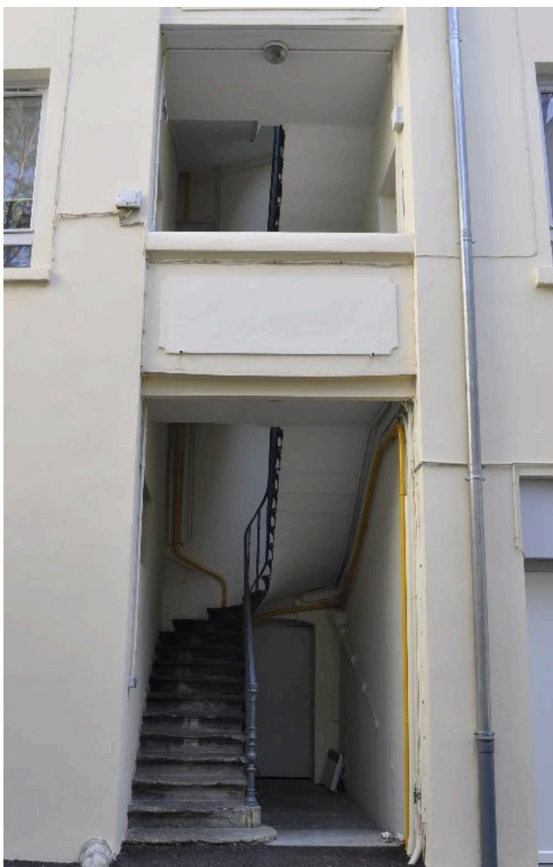
Immeuble sur cour, escalier à cage ouverte
