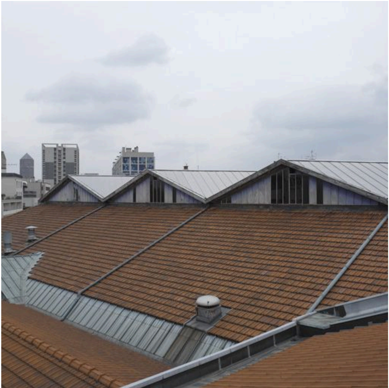
La couverture de la grande salle, ex patinoire, depuis le nord
