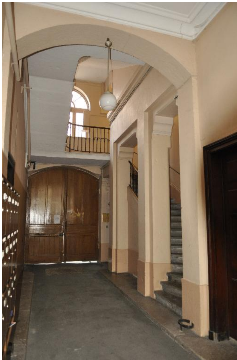
Vue intérieure : le passage cocher surmonté de l'escalier
