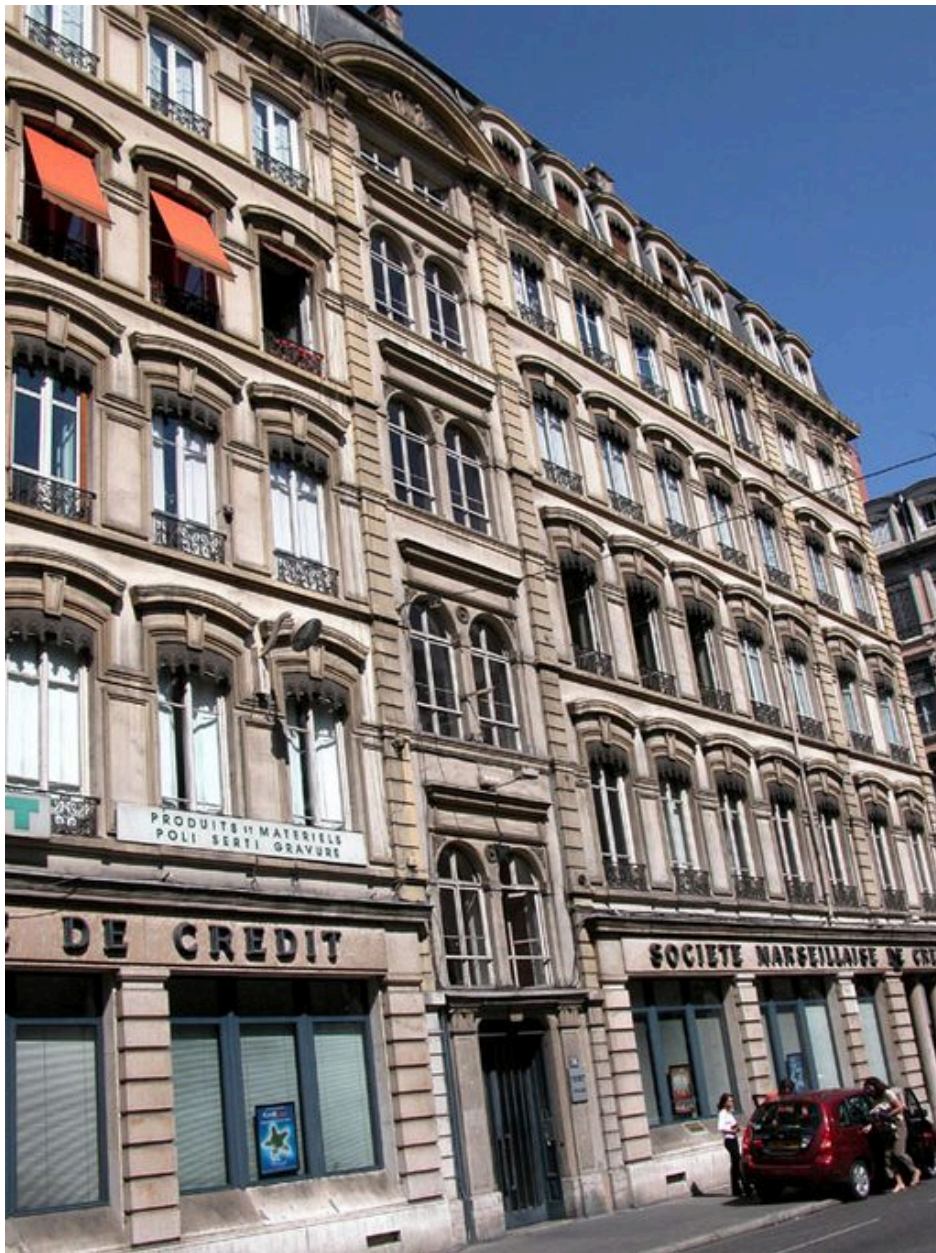
Vue partielle de l'élévation sur la rue du Président-Edouard-Herriot
