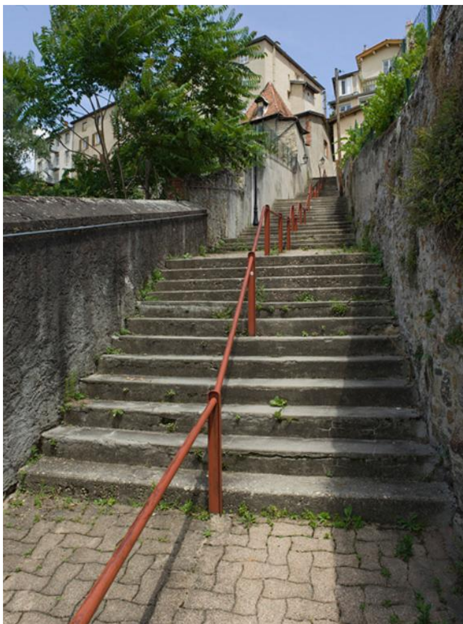
La rue, aménagée en escalier, en direction du haut.
