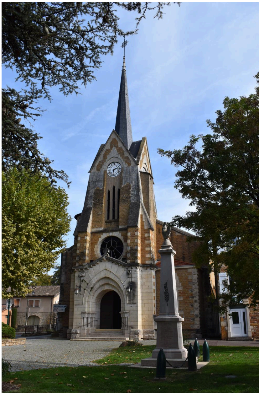
Vue générale depuis la rue du Beaujolais
