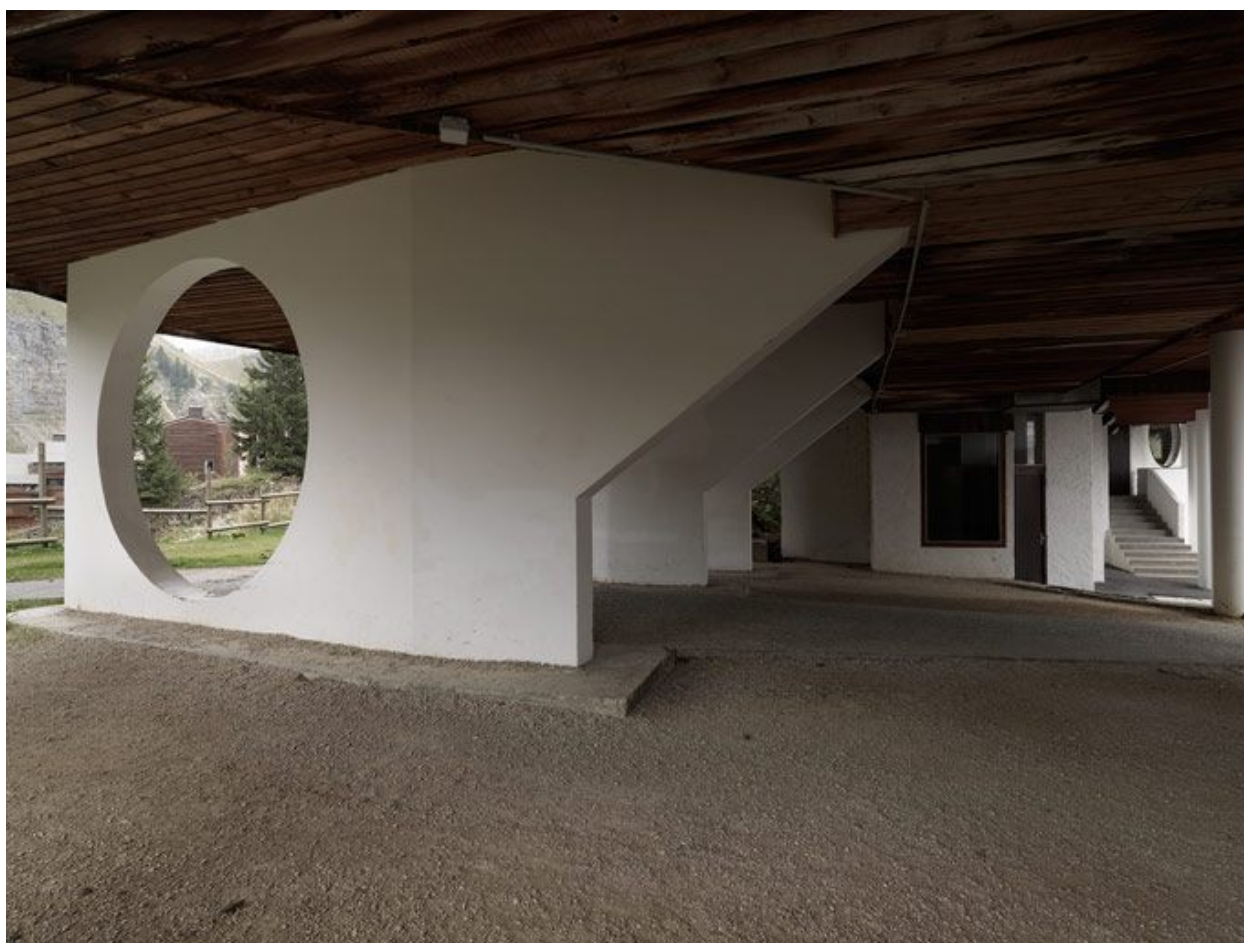
Passage en soubassement avec murs de refend évidés
