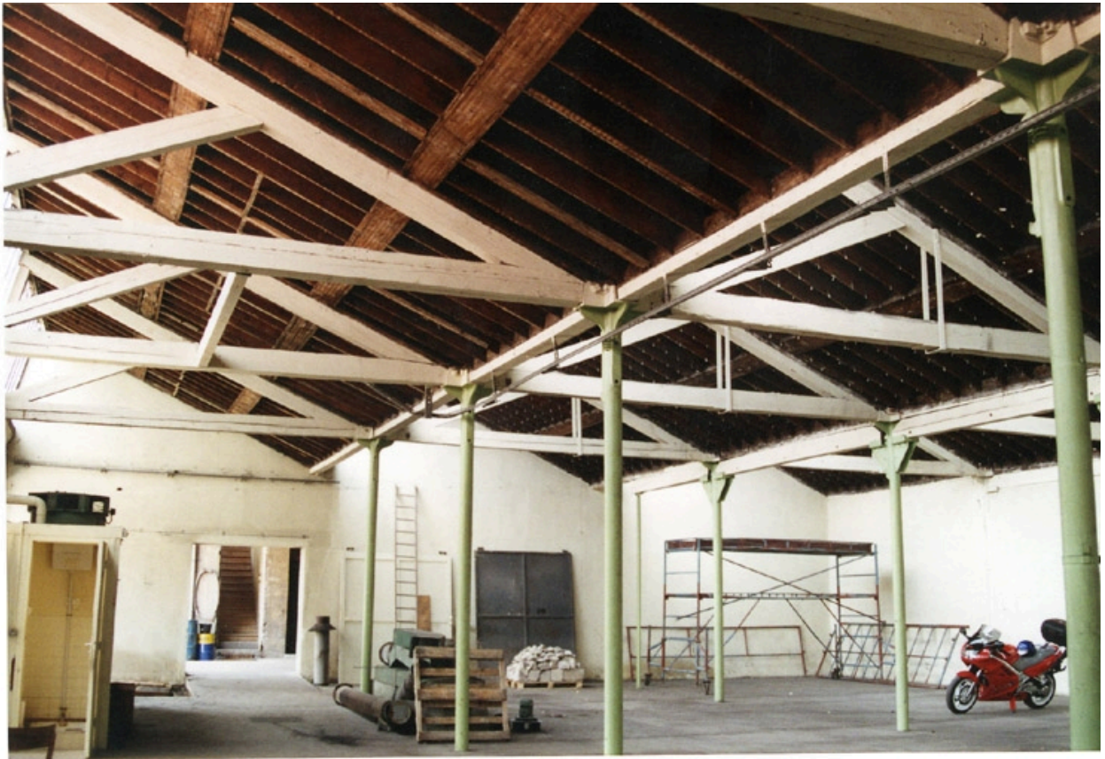
Chantier en 1994 : réhabilitation du site. Ecole Emile Cohl Archives privées. Ecole Emile Cohl
