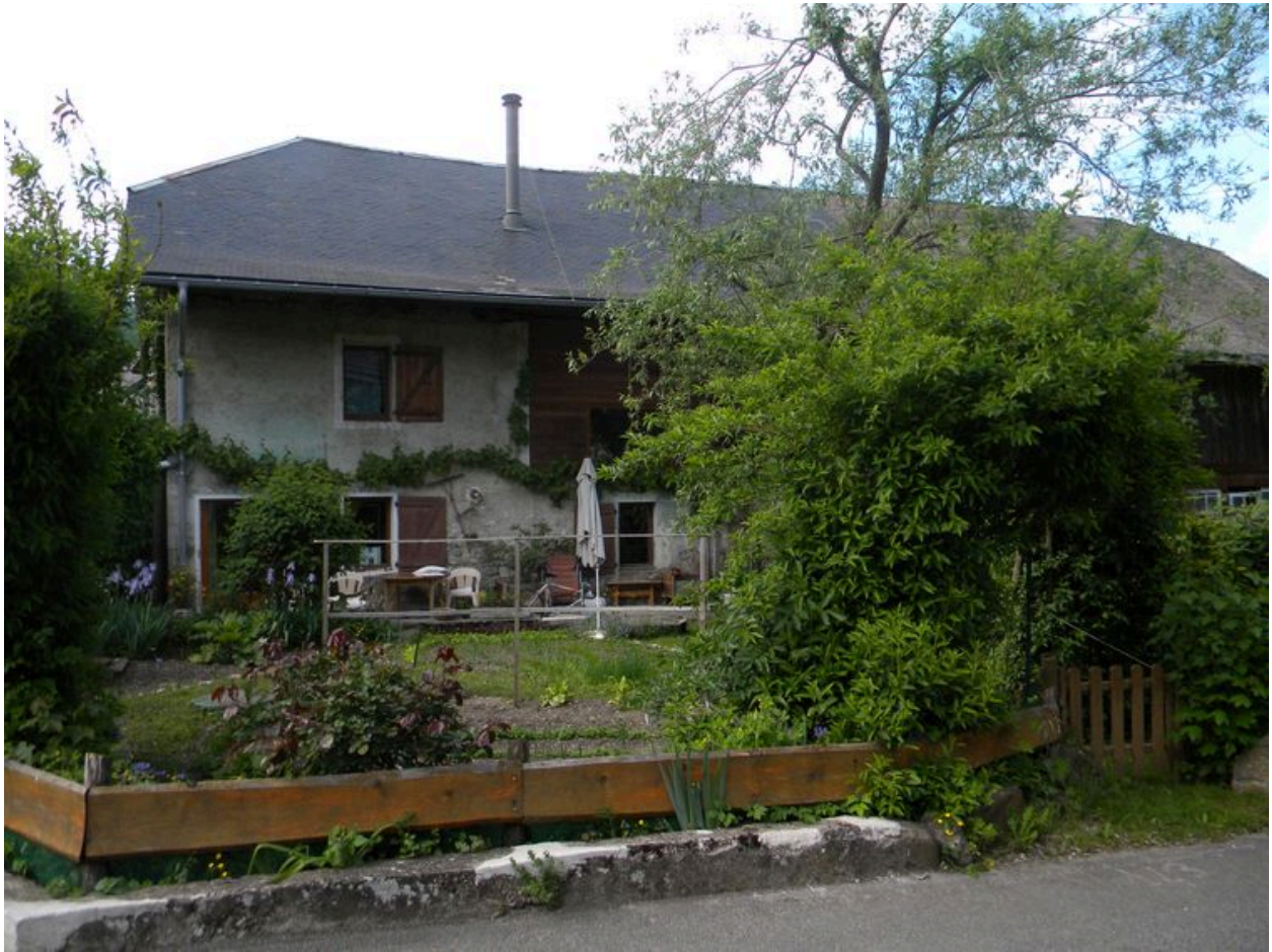
Façade principale d'une ancienne ferme (2008 C81304).
