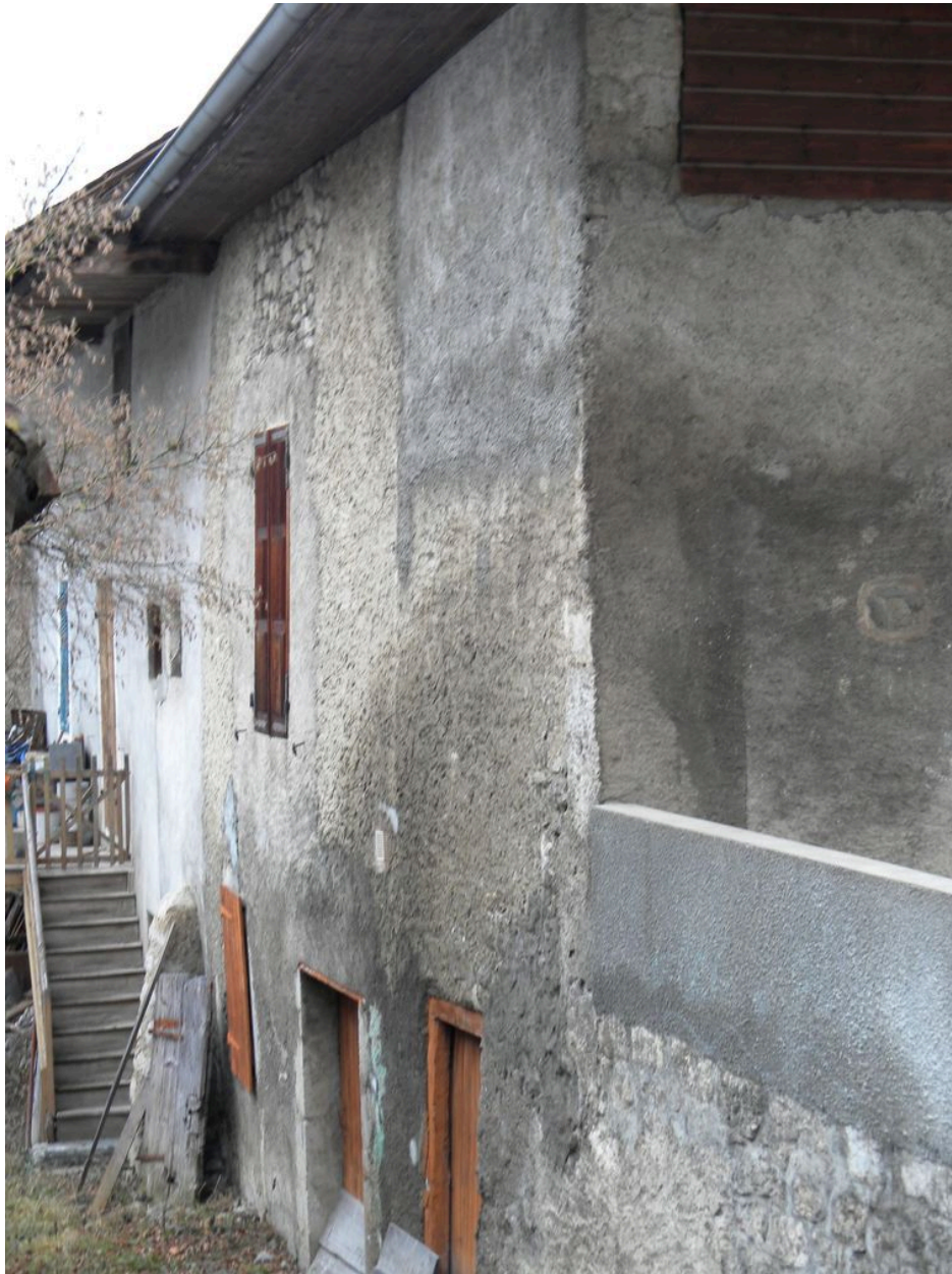
Vue du mur sud avec ouvertures des parties agricoles.
