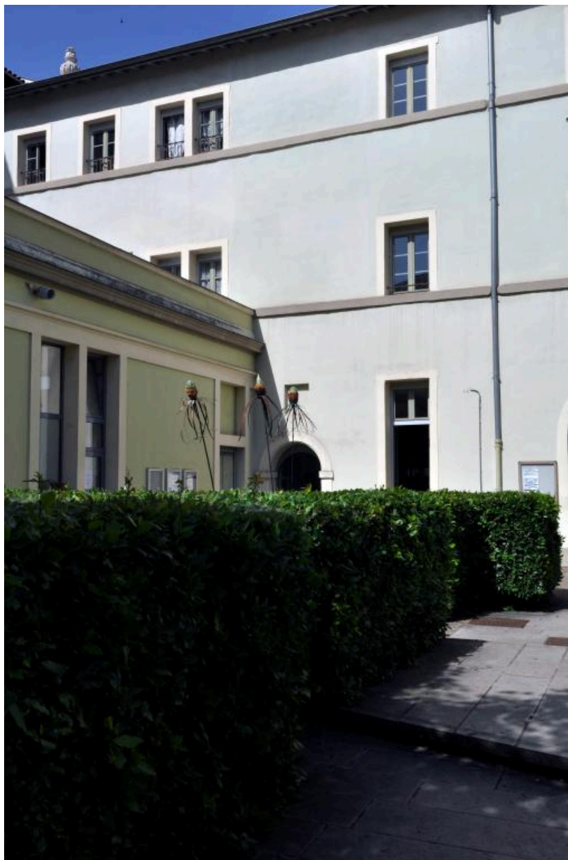
Cour 1 : jonction entre les bâtiments A et B
