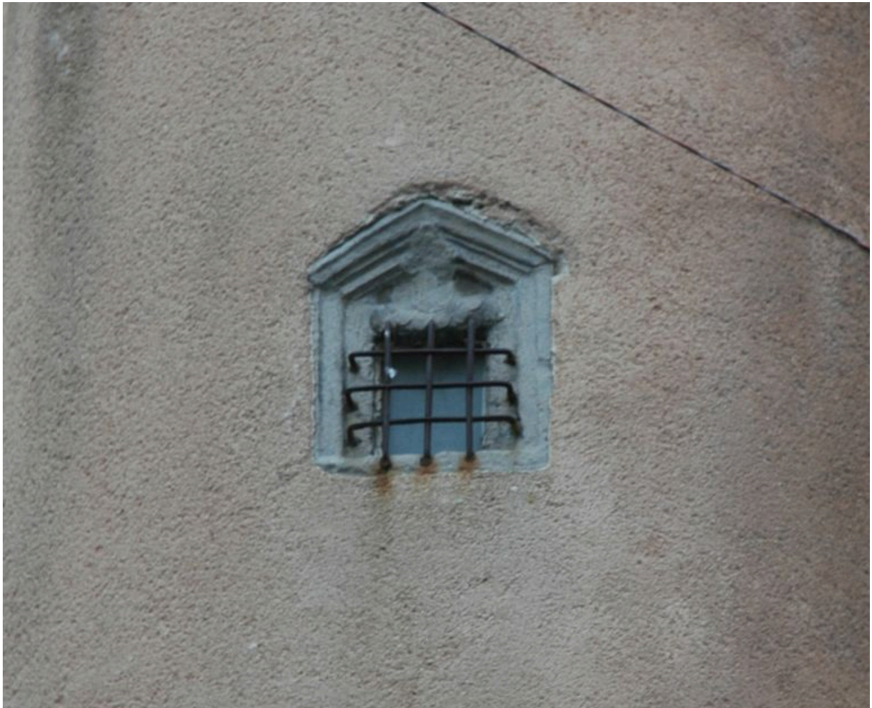
Petite baie d'aération dans l'échauguette d'angle.
