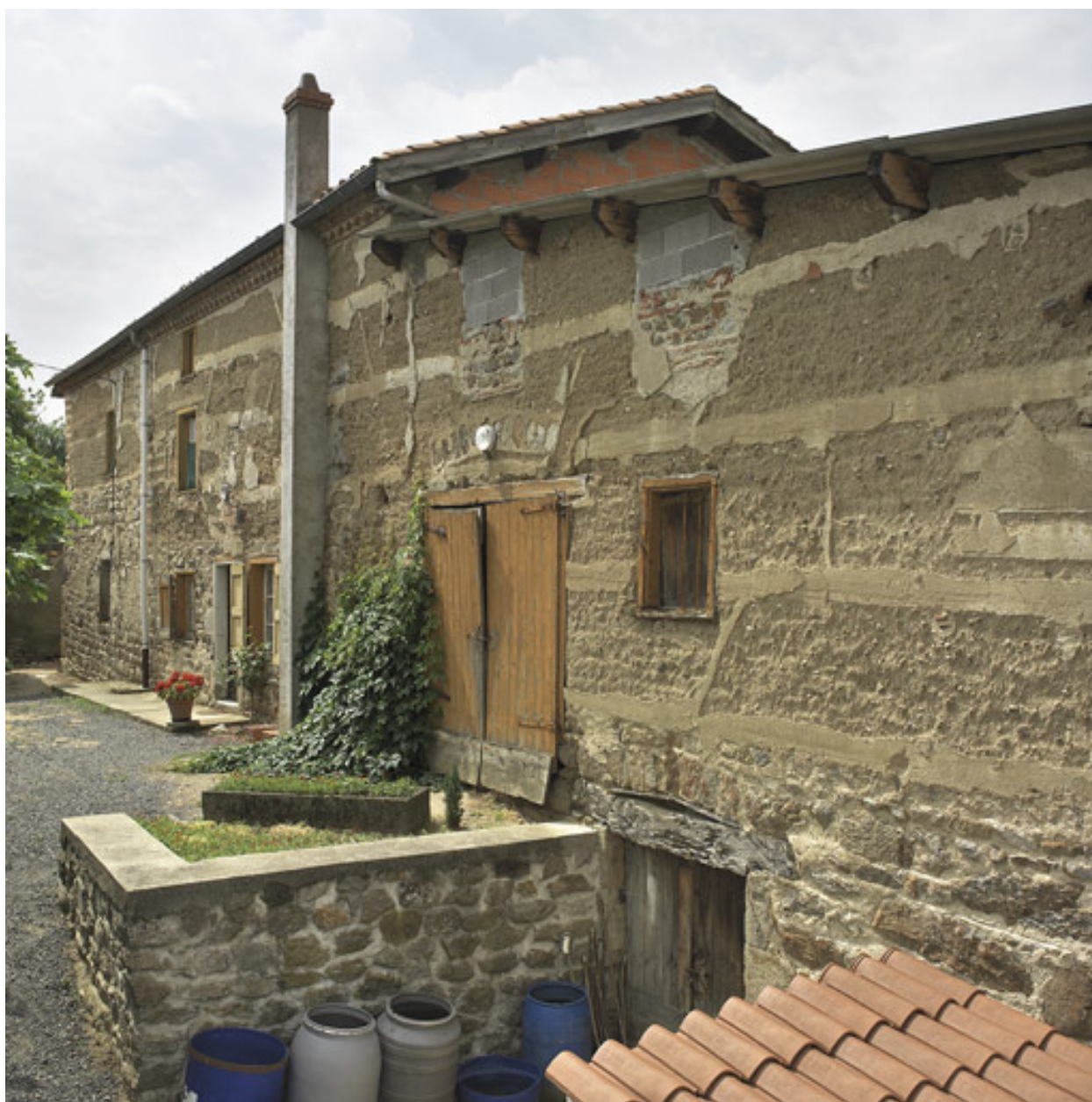
Vue générale du logis et de la grange, avec l'accès à la cave, depuis le nord.
