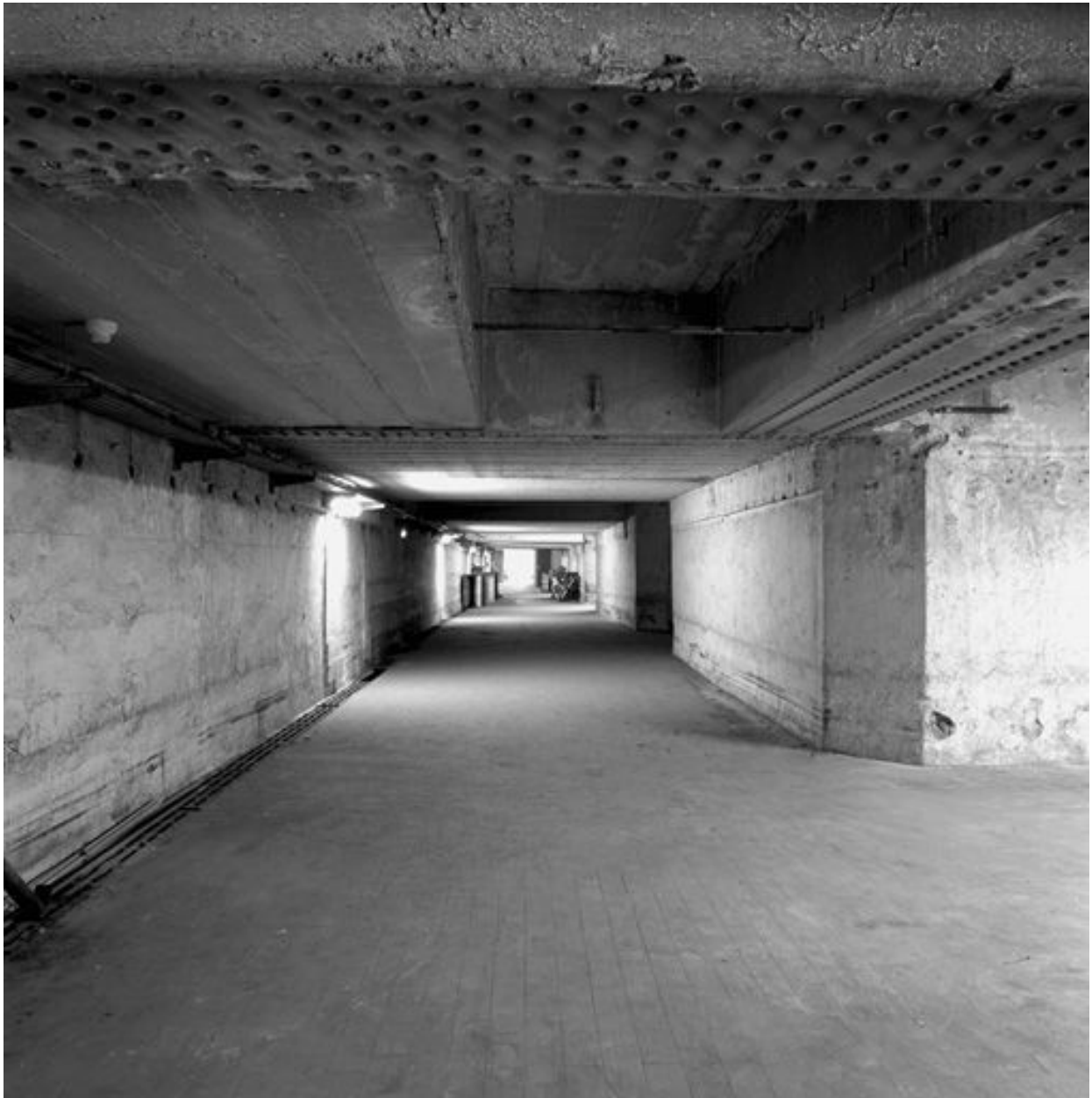
Le bâtiment-voyageurs : souterrain
