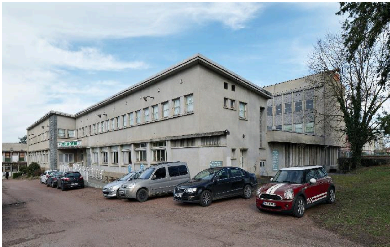
Bâtiment HI : vue d'ensemble depuis le sud-est
