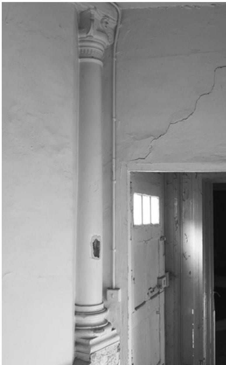
Corps de bâtiment nord. 1er étage. Colonne engagée dans le mur sud
