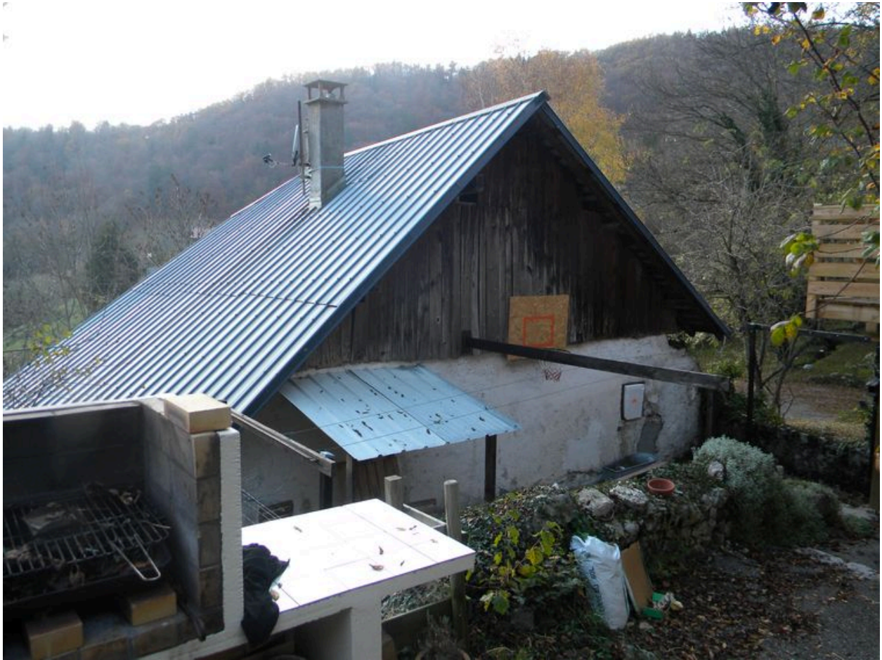
Façade arrière d'un ancien cellier transformé en habitation. (2008 A8 1864)
