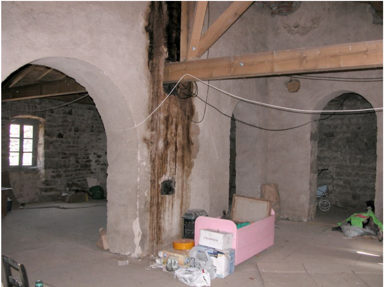
Vue intérieure du comble à surcroît du logis de la ferme. Ouverture pratiquée dans la tour à droite.
