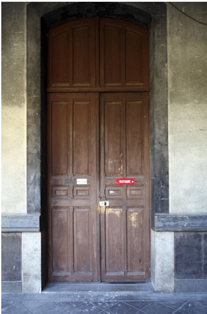
Cour H. Galerie supérieure. Entrée d'une salle de cour.
