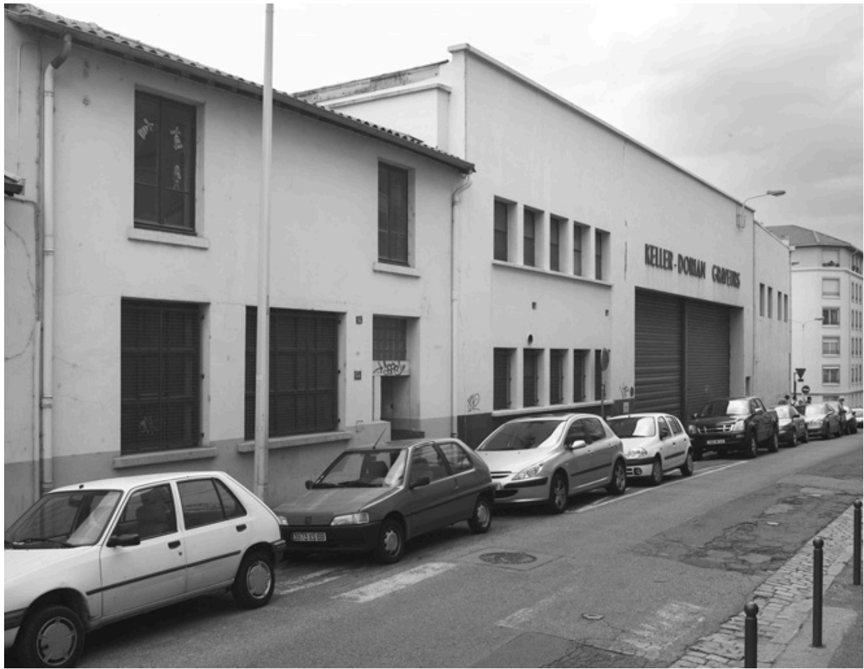
Détail façade nord-est de 1962.
