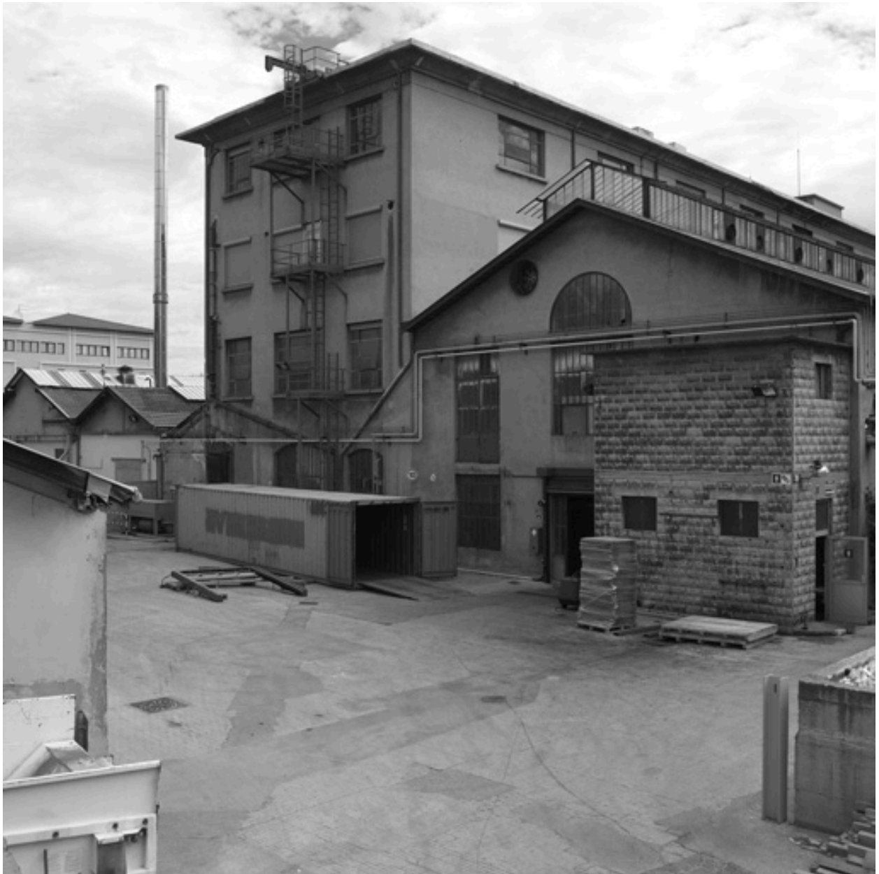
Vue d'ensemble avec cheminée métallique
