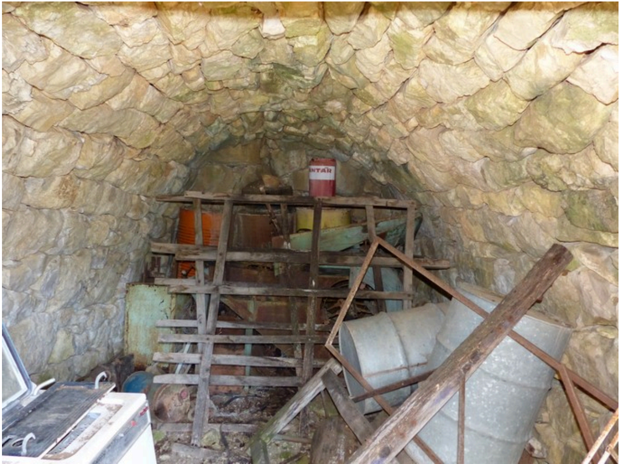
Vue de volume prise du sud.
