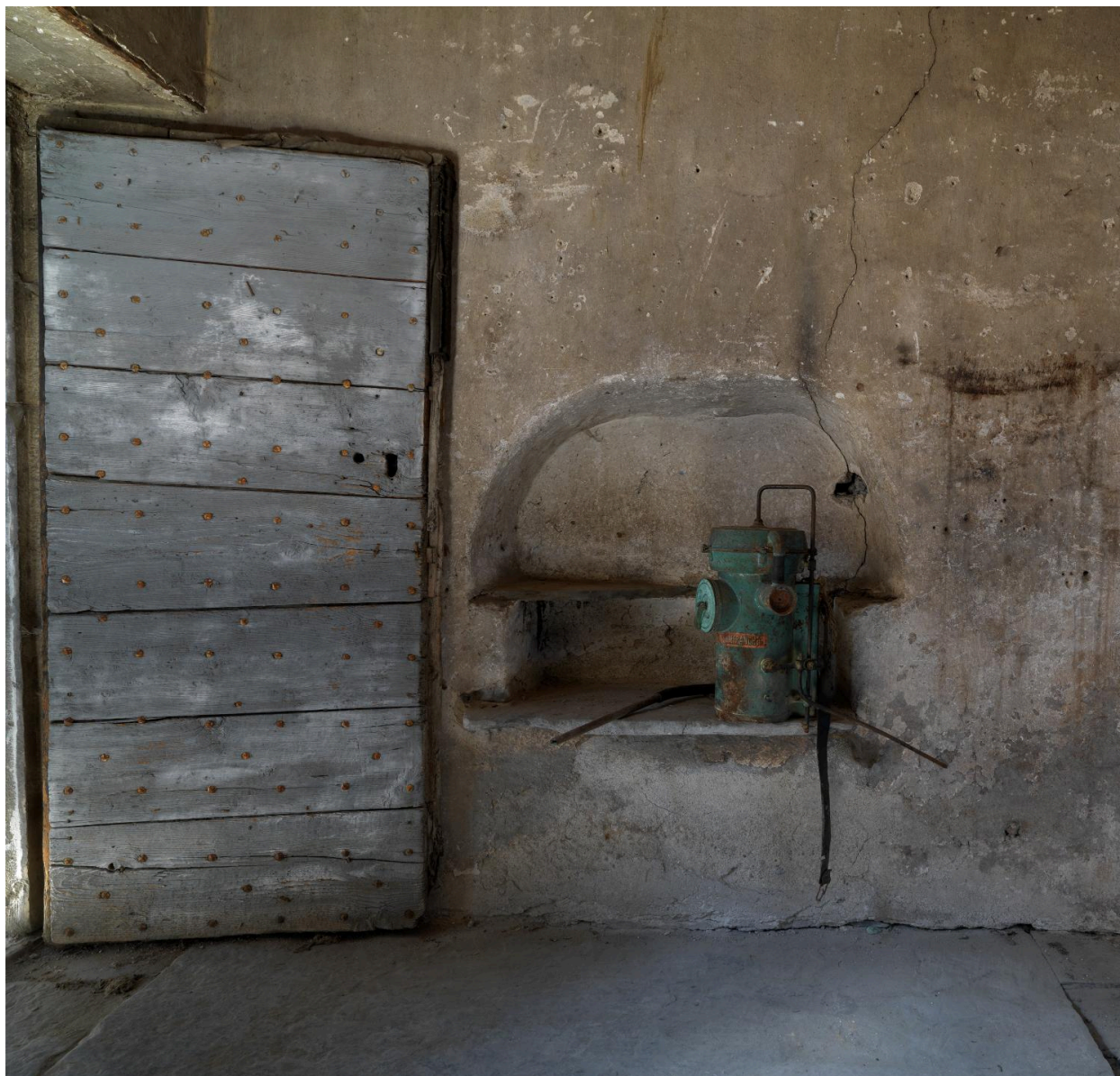
Vue intérieure de la cuisine B : niche à eau et sulfateuse.
