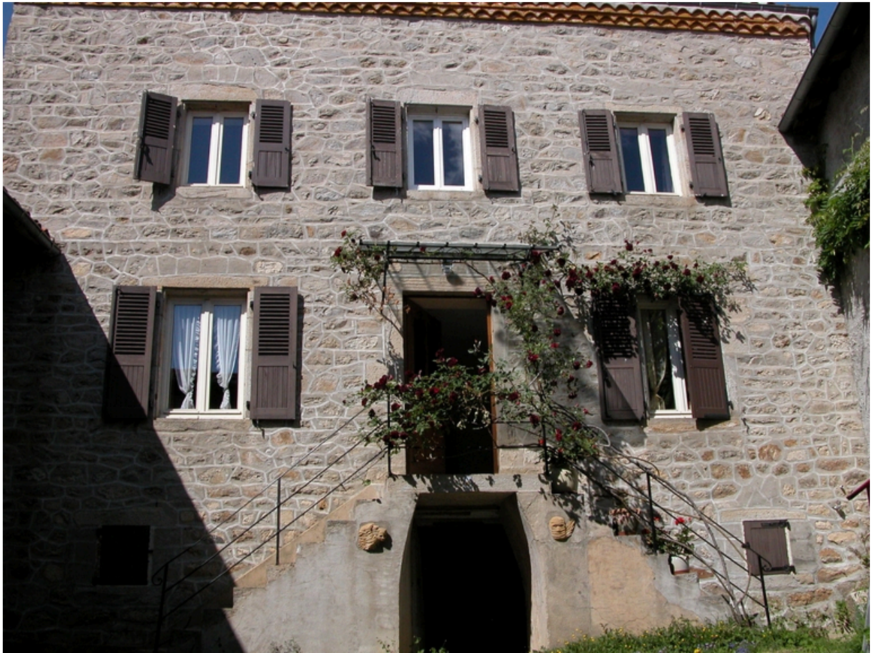
Vue d'ensemble de la façade sur cour.
