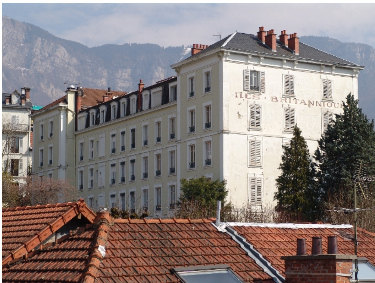
Vue prise du nord-ouest
